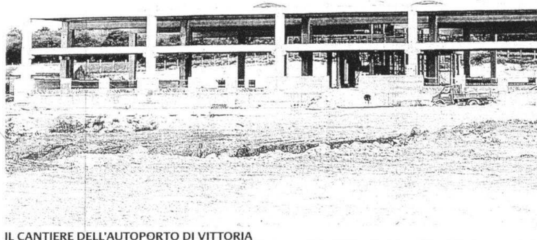
IL CANTIERE DELL'AUTOPORTO DI VITTORIA
